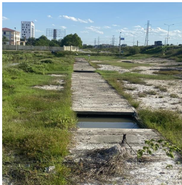
Tuyến mương hiện trạng tại dự án
